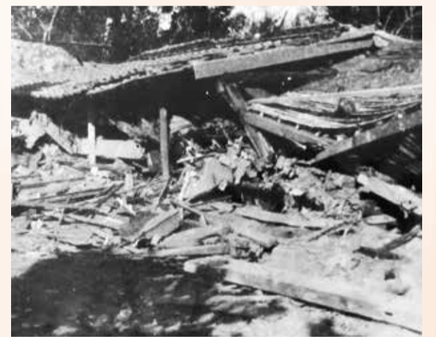
西尾市丁度町の民家倒壊
