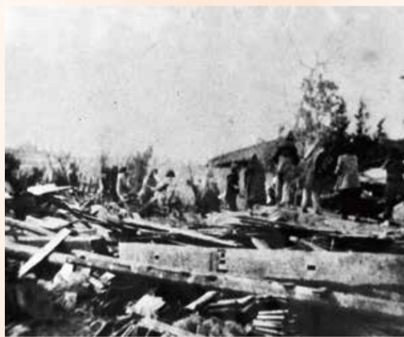
西尾市吉田小学校の倒壊
